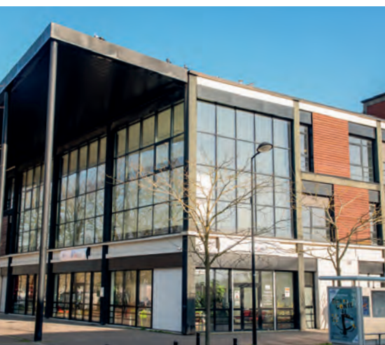
Pépinière d'entreprises «Chrysalead»
